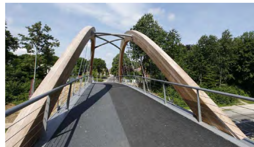
Fiets- en voetgangersbrug met rechte lange landing
