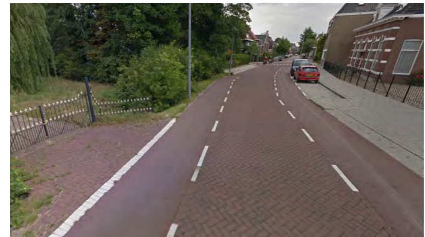
Oude lintweg zoals Kruisstraat rijweg met klinkers
